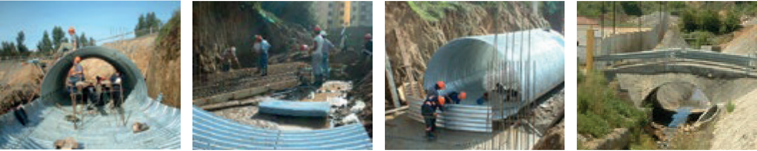
Estructuras Súper Span Américo Vespucio
